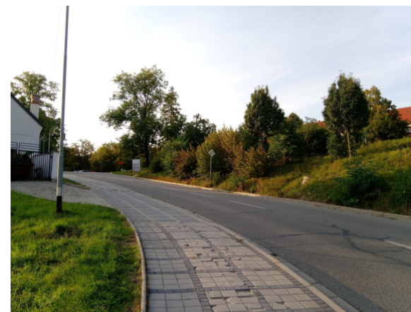
Plocha mezi ul. U žlebu a Hradištskou vyrovnává velké převýšení
